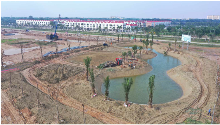
Hồ cảnh quan - một điểm nhấn tại khu vực quảng trường đang được đẩy nhanh tiến độ thi công và dự kiến sẽ hoàn thành vào trong tuần tháng 12 này.
